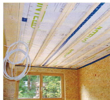
Feuchtevariable Dampfbremse unter einer Terrasse
